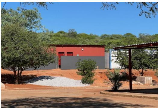
Toiletgebouw in aanbouw
