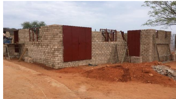
multifunctionele ruimte met eetzaal en keuken in aanbouw
