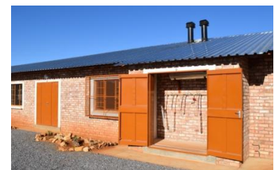
af te sluiten ruimte voor de gasflessen
